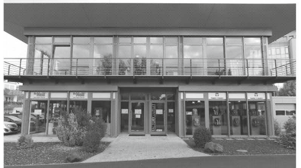
Die bunten Schultaschen im Parterre gibt es nicht mehr. Jetzt sucht HZ-Bau einen Nachmieter. . Foto: Karl-Heinz Riedel
